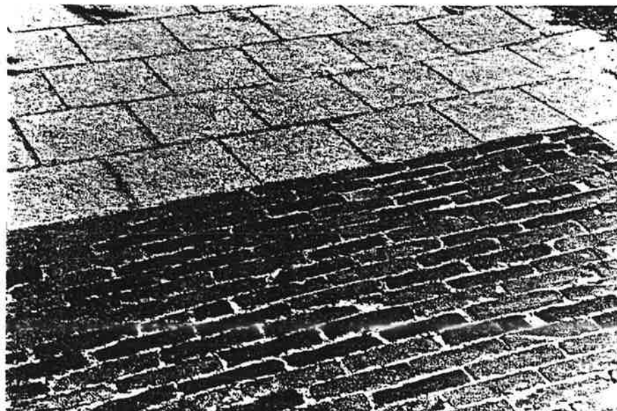
figuur 85. een klinkerverharding laat door een groter aantal voegen beduidend meer water door dan een tegelverharding
